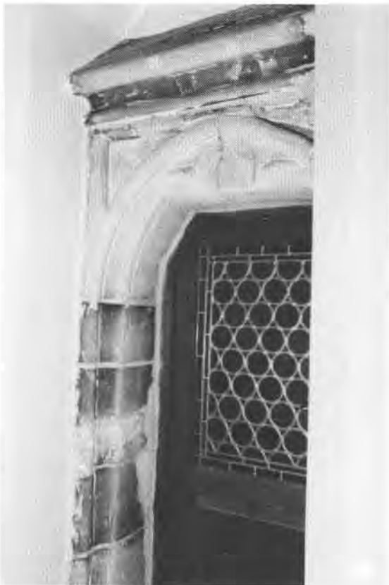
14. De mergelomlijsting van de wandopening tussen de traptoren en het balkon.
