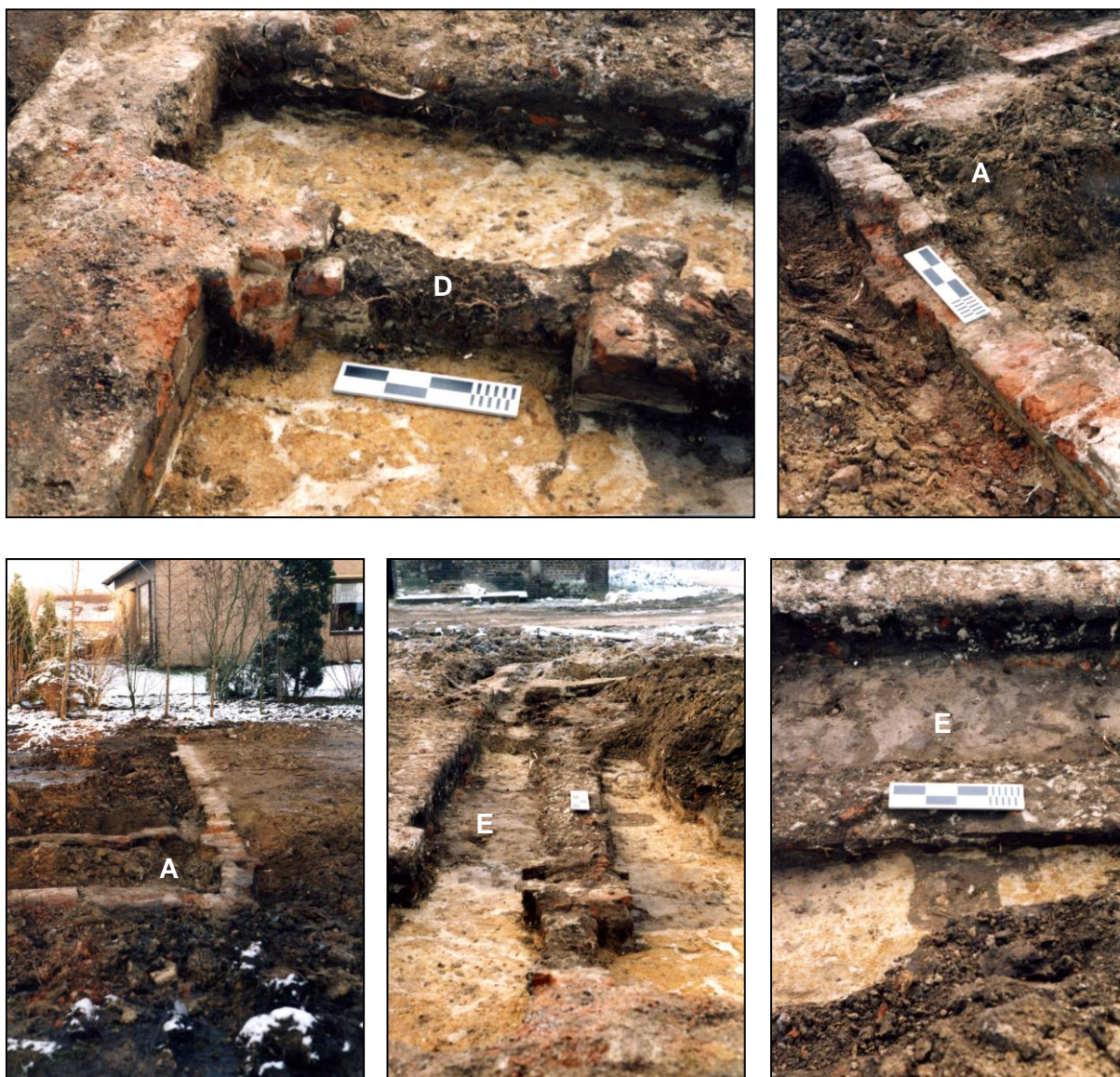
Figuren 10 t/m 14. Detailfoto's van funderingen. De locatieletters verwijzen naar figuur 8.
